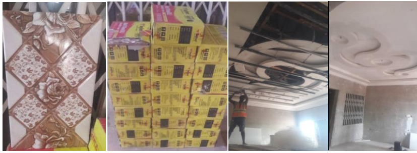
Fliesen, Zement und Arbeiten an der Decke am Eingang – zu tun ist immer genug
