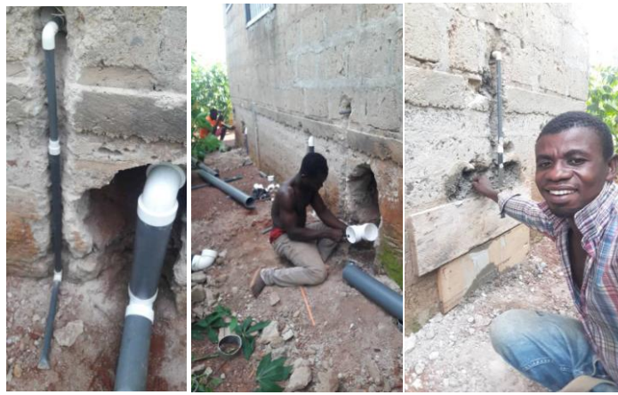
Die Rohre hat Kofi mit seinem „Lehrling“ eingepasst und auch die Wände hat er selbst verputzt.
