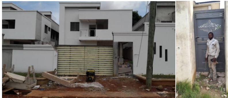
Hier noch ein paar Bilder von Kofis Arbeit. Das Tor ist mehr als 6 m lang. Die Schienen dafür fertigt er auch an, sie werden in den Erdboden gehauen und dann muß das Tor laufen. Ihr seht auch neue Wohnblocks, an denen er mitarbeitet.. Das kleine Tor ist wunderschön verziert, eine schwierige, weil sehr feine Aufgabe.
